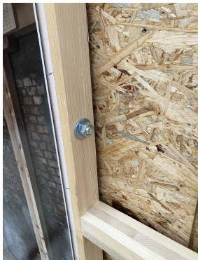
Fixation des cadres par boulons et écrous (fournis)
