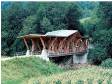
Fig. 10: Pont couvert des Ravines sur le Doubs vers Saint-Ursanne, année de construction: 1992, ingénieur bois: J. Natterer (© Andrea Bernasconi, HES-SO Yverdon/LIGNUM)
