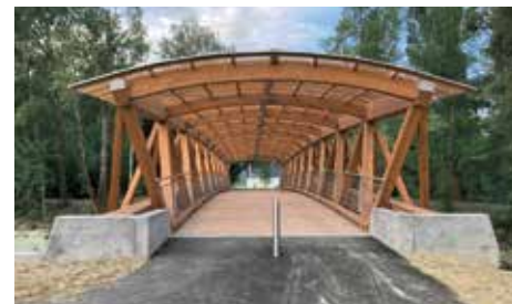
Fig. 11 : Passerelle couverte sur la Borgne, Bramois 2022. Ingénieur bois : Charpente Concept SA, Nax; Ingénieurs civils : PRA Ingénieurs Conseils SA, Sion (© PRA Ingénieurs Conseils SA)
