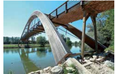
Fig. 7 : Pont sur la Broye, Sugiez FR, 2001. Ingénieur bois : Chabloz et partenaires SA, Lausanne (© Corinne Cuendet, Clarens/LIGNUM)
