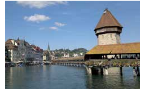
Fig. 2 : Le Kapellbrücke à Lucerne, en Suisse, est l'un des anciens ponts couverts en bois d'Europe, construit en 1333. Il a survécu jusqu'à aujourd'hui (avec quelques restaurations).
