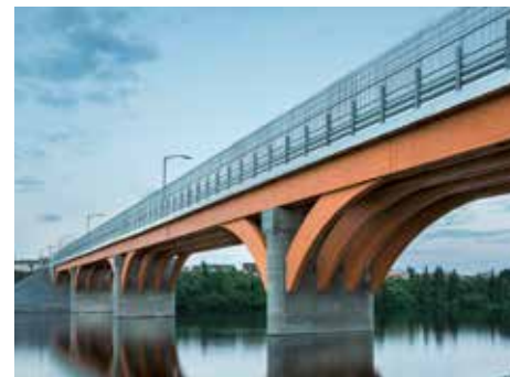
Fig. 5 : Le pont de Mistissini au Canada, un pont en bois lamellé de 160 mètres de long, est l'un des plus longs ponts de ce type au monde. (© Stéphane Groleau)
