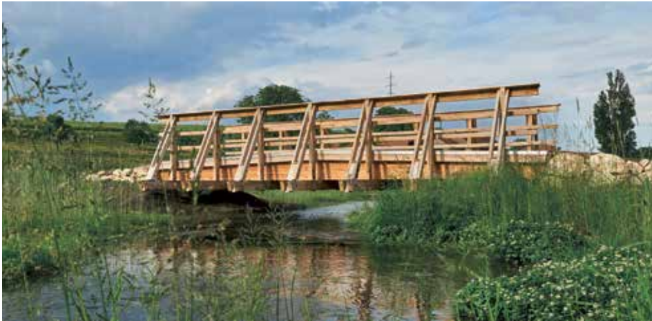
Fig. 6 : Passerelle du Bey, Montagny-près-Yverdon, 2021. Ingénieur bois : Ratio Bois Sàrl, Ecublens (© Corinne Cuendet, Clarens/LIGNUM)
