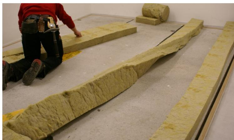
Abbildung 3: Vorbereitung zum Stopfen der Fugen (Foto: Empa)
