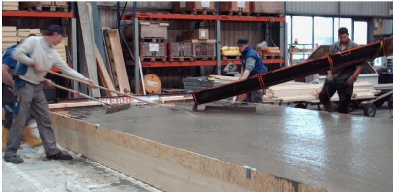
Abbildung 1: Herstellung der Rohdecke
