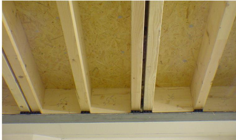
Abbildung 2: Untersicht der eingebauten Rohdecke auf elastischen Lagern (Foto: Empa)
